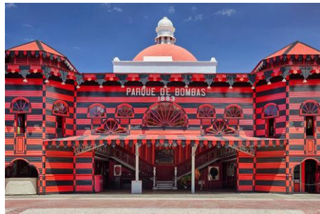
Parque de Bombas
