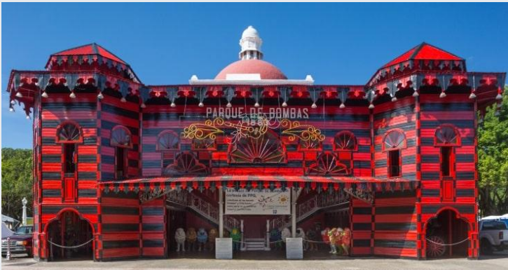
Parque de Bombas
