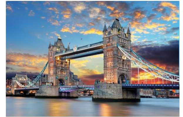
Puente de la Torre
